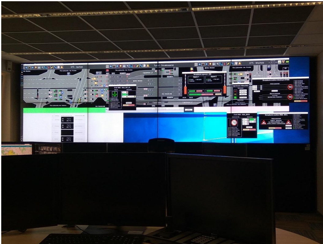
Рисунок 3.3 – Екран системи управління сучасним транспортним тунелем (м. Катовіце, Польща)
