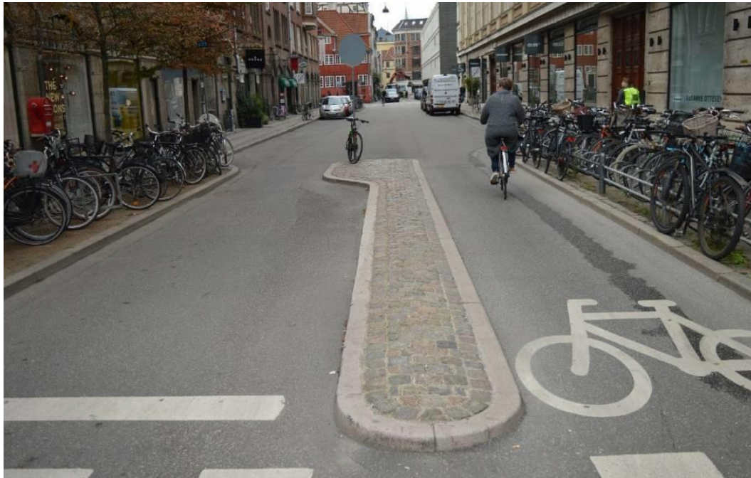
Рисунок 4.2.35 – Розділові смуги, які підняті над ПЧ на перехресті (примиканні) (Джерело: [37])
