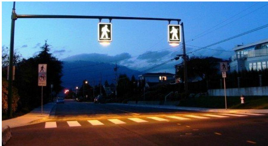
Рисунок 4.2.24 – Додаткове автономне освітлення зони нерегульованого пішохідного переходу в темну пору доби (Джерело: https://odessa-life.od.ua )
