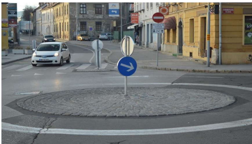
Рисунок 4.1.25 – Кільцева розв'язки на міському перехресті (міні-кільце) (Джерело: ДСТУ 4123:2020)
