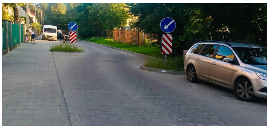
Рисунок 4.1.24 – Штучні повороти (шикани) (Джерело: ДСТУ 4123:2020)
